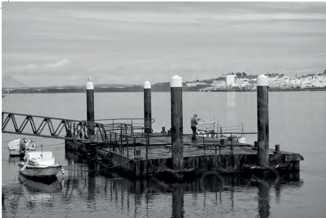
Muelle del ferri de Ayamonte a Vila Real de Santo António.
