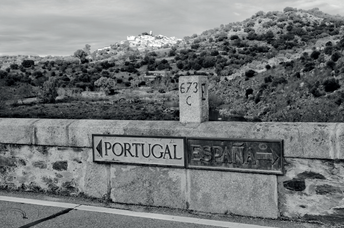
Puente fronterizo sobre el río Erjas.
